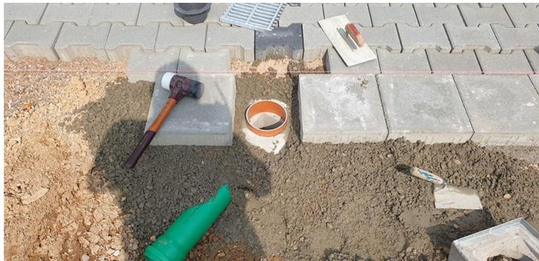
Fügen Sie den Verbinder ein, bei allen Aufsätzen aus Guss ist dieser am Rahmen angegossen, und werfen erdfeuchten Mörtel auf den Rand des Bodenteils.
