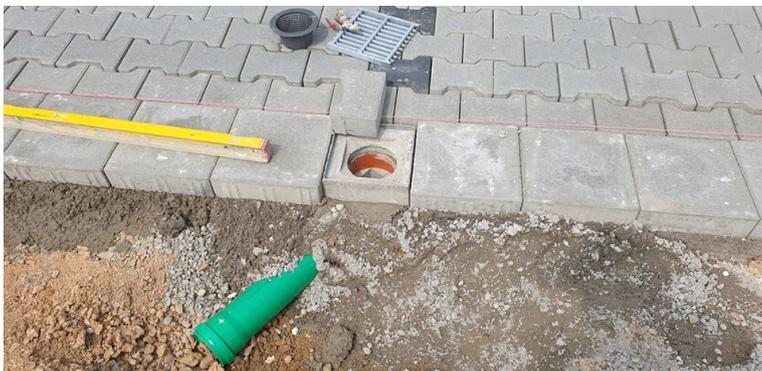
Setzen Sie den Aufsatz auf und richten ihn per Augenmaß aus. Eine Wasserwaage benötigen Sie nicht.
