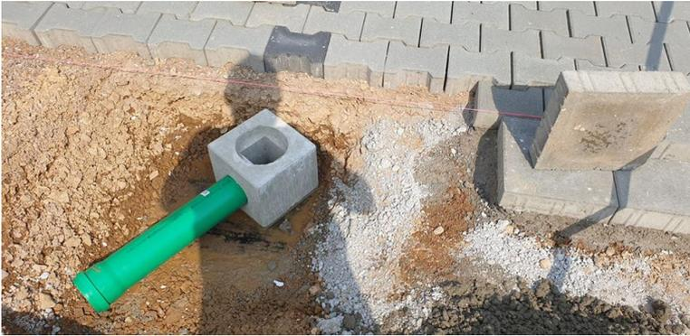
Setzen Sie das Bodenteil bei angenommen fertiger Höhe von 0,00m, mit Unterkante Bodenteil auf -0,37m oder -0,38m mit der Muffe in Richtung des Abzweiges zur Grundleitung, ohne auf Fugen oder Pflaster zu achten. Es darf auch etwas schief stehen, da alle Aufsätze auch etwas schräg aufgesetzt werden können. Bögen zum Anschluss benötigen Sie nicht.
